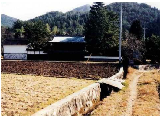
① 伊藤家の土蔵遠景
