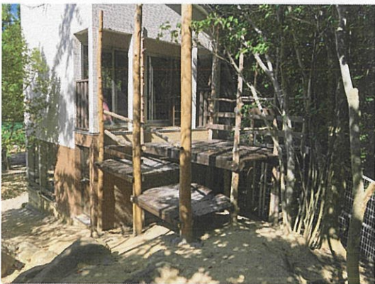
階段状のデッキにすることで、同船が太くなり、安心・安全な上り下りができるようになった
