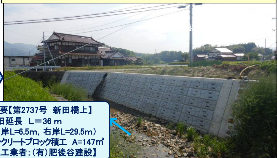
河川護岸の災害復旧工事が完成(令和2年3月)
