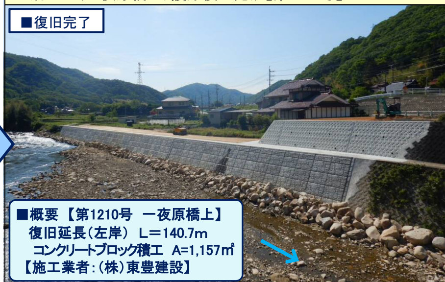
沼田川(一夜原橋上)護岸復旧完成【第1210号】
