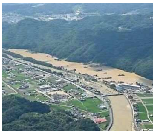
河川氾濫による浸水状況(三原市本郷町)
