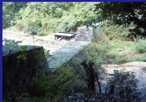
坂町 天地川砂防堰堤(昭和22年頃)
