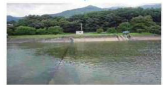
ゴム堰が倒れた状態
