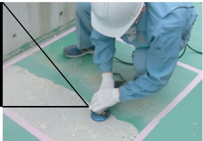
コンクリート表面の塗装ハガシ作業
