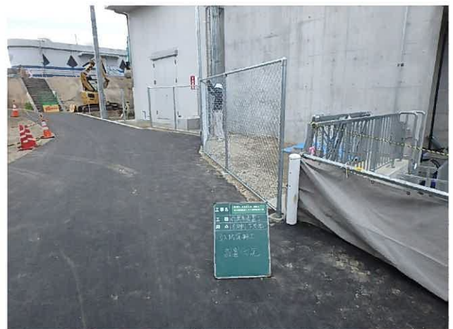
立入防護柵設置状況
