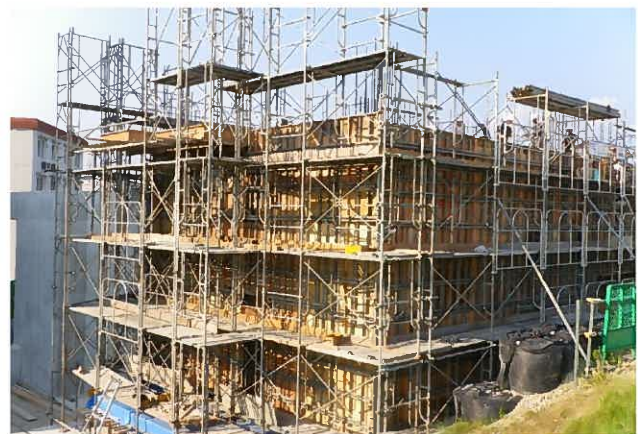
型枠組立状況
