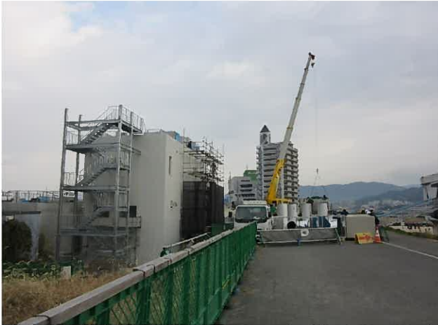
自家発電装置消音器搬入状況
