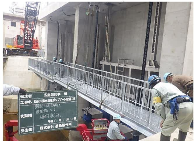
管理橋据付状況
