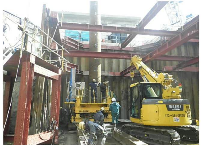
鋼管杭打設状況
