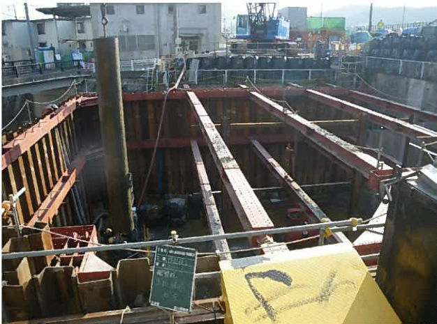
鋼管杭打設状況
