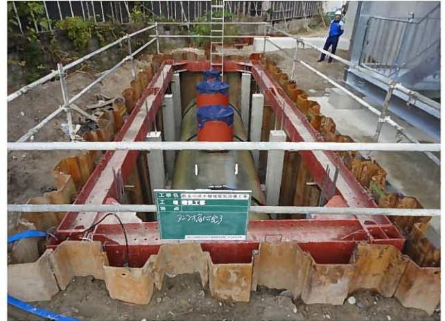
自家発電用地下燃料タンク施工状況
