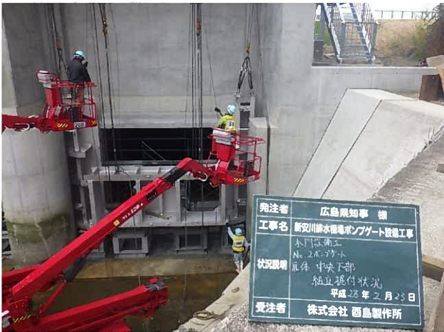
扉体組立据付状況
