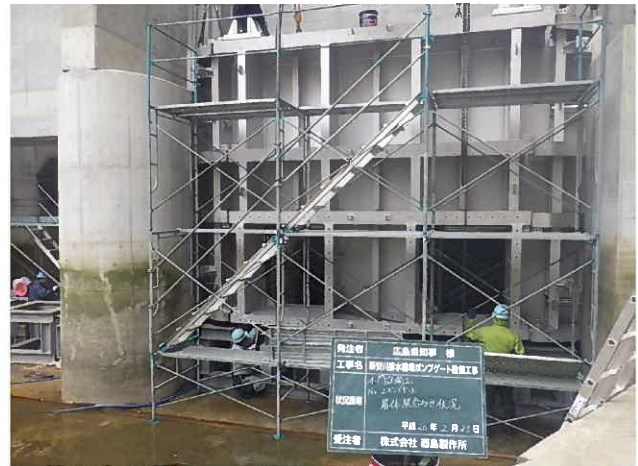
扉体肌合せ状況
