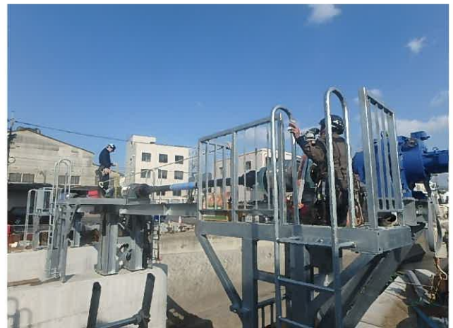
引き上げ装置据付(芯出し)状況
