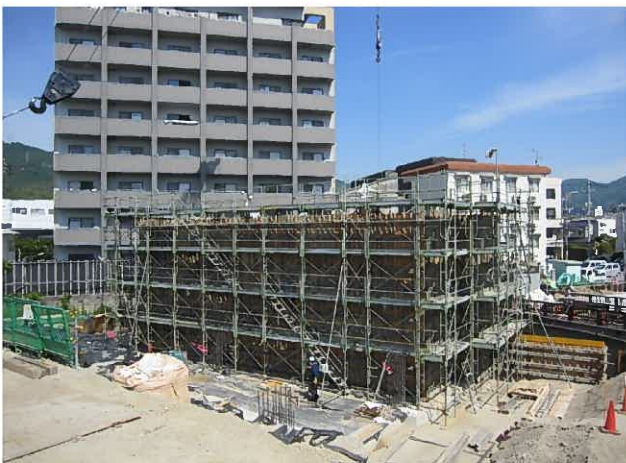
型枠組立状況
