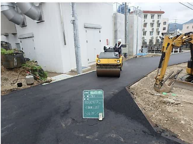
市道舗装状況
