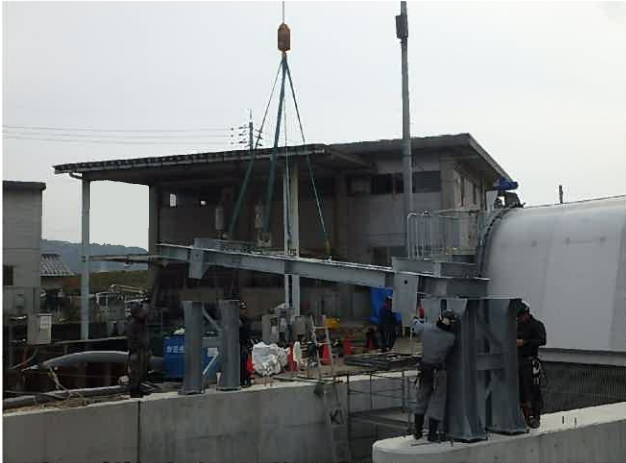
引き上げ装置架台設置状況
