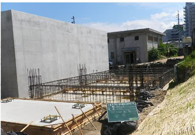
基礎配筋組立施工状況
