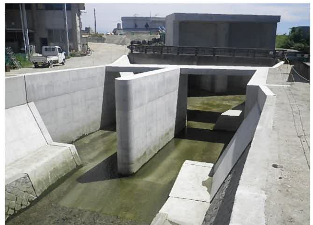
土木設備完成状況
