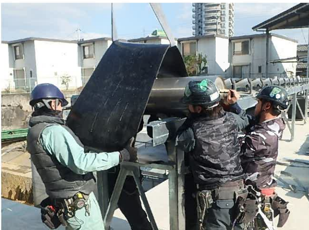
水平ベルトコンベヤ据付状況
