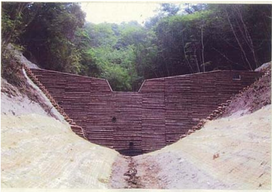
【施工後の状況】
