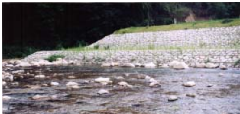
【改修後の状況】
