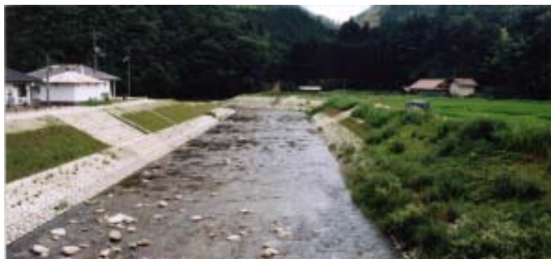
【改修後の状況】
