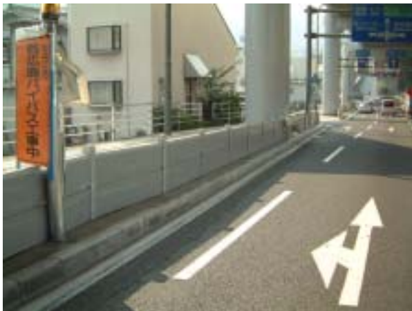
【街路部の歩道に低層遮音壁を設置】
