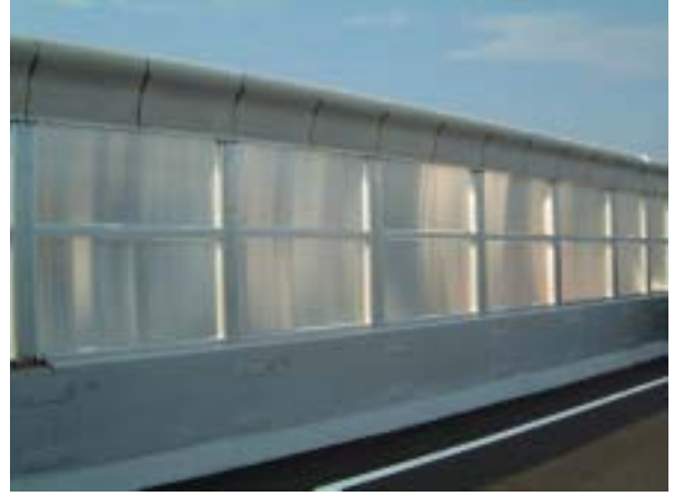
【高架部に先端改良型遮音壁を設置】
