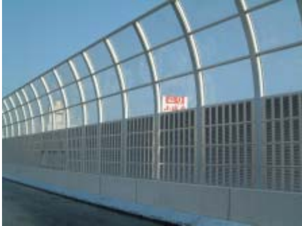
【高架部に遮音壁を設置】
