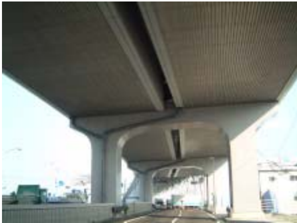
【橋桁に裏面吸音板を設置】
