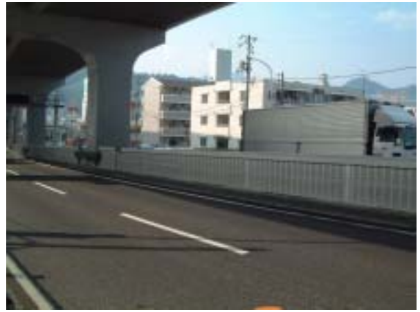
【街路部の中央分離帯に低層遮音壁を設置】
