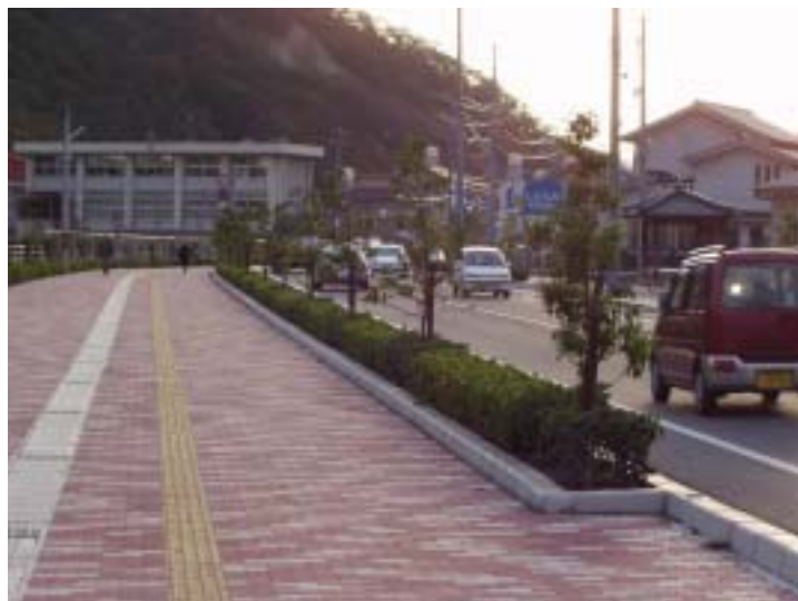
【施工後の状況(植樹帯の設置)】
