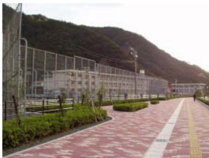
【施工後の状況(植樹帯の設置)】
