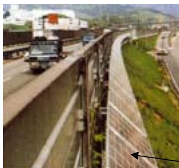
【道路空間利用の太陽光発電】
