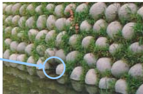
【底面の一部をすかしたブロック積】
