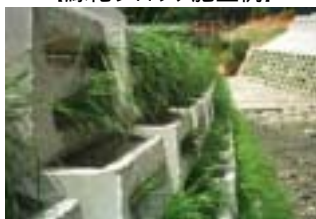
【緑化ブロック施工例】
