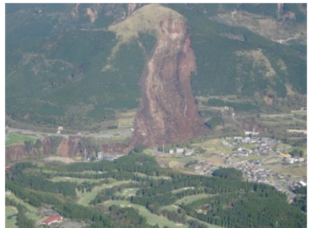
・地震による土砂崩れで道路が寸断された南阿蘇地区
