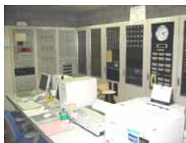
中央監視盤装置
