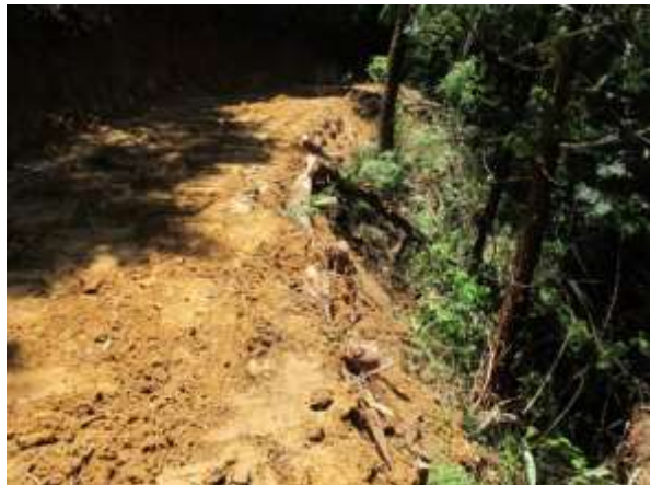
写真4 完成した作業道
