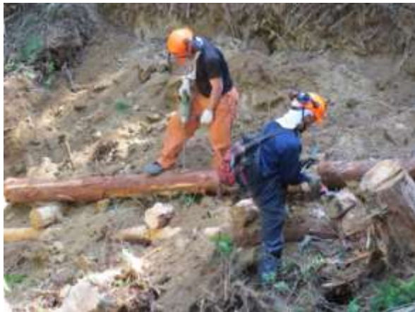
写真3 丸太組み作業
