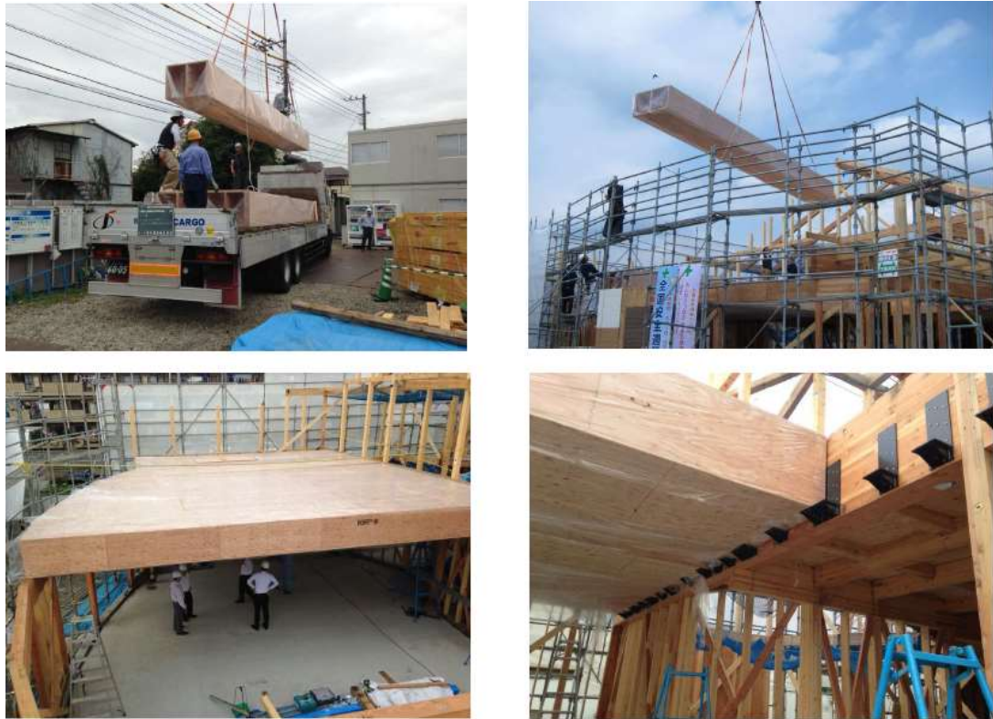
写真1 LVL ストレススキンパネルの施工(平成 26 年 6 月 30 日東京都小平市立鈴木保育園)
