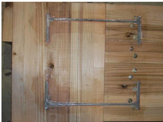
図1 H型鋼と補強した接合部
