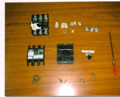
各部品に分解した配線用遮断機
