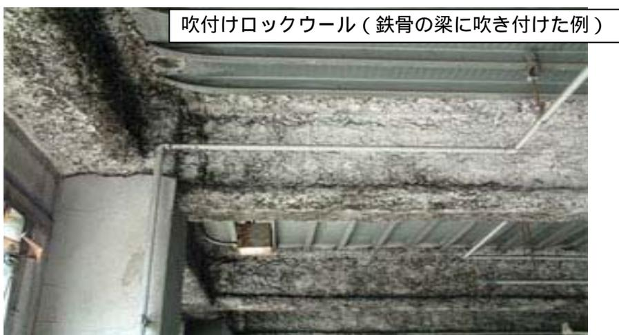
粒状吹付け材：表面に粒状の凹凸が見られる。
