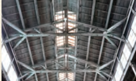
(例) ヤマトロックマシン東城工場の屋根裏は、美しいトラス構造です。
