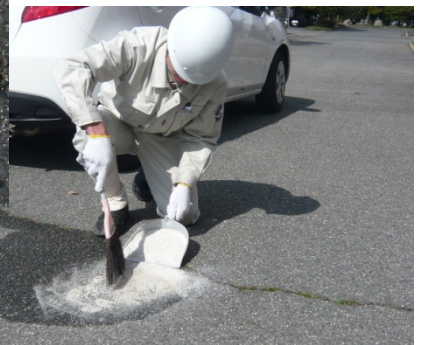
油吸着後の回収作業の様子
