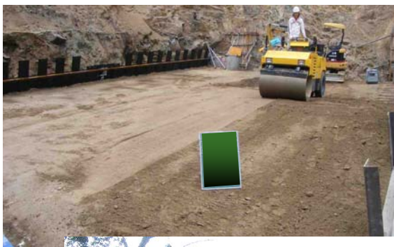
建設発生土を有効利用した砂防えん堤の工事
