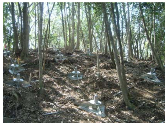
斜面を鋼製ワイヤーで補強する工法によるがけ崩れ対策
