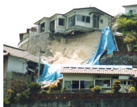
▲ 呉市で発生した宅地擁壁の崩壊
