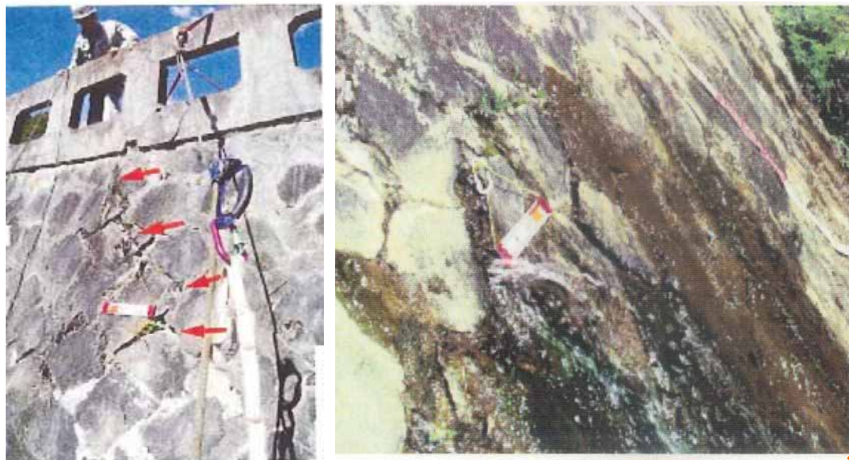
クラックと漏水の状況
