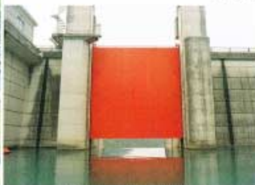
▲放流設備(クレストゲート)
