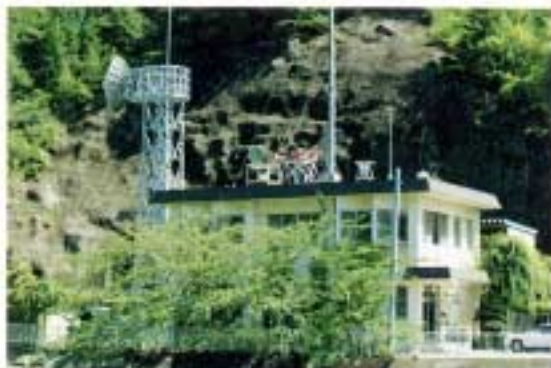
▲ダム放流警報所
