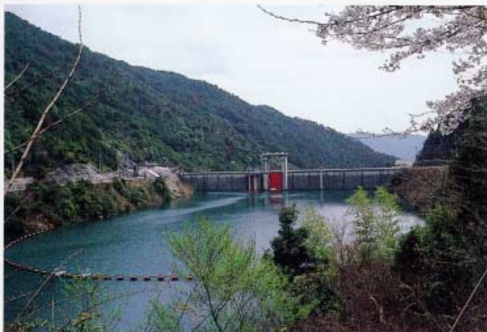
上流よりダムサイトを望む
