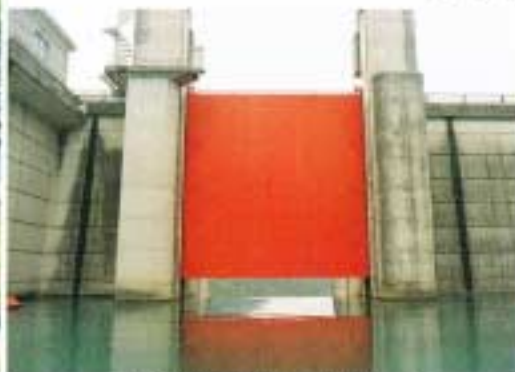
▲放流設備(クレストゲート)
