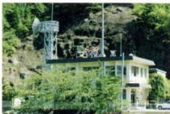
▲ダム放流警報所
