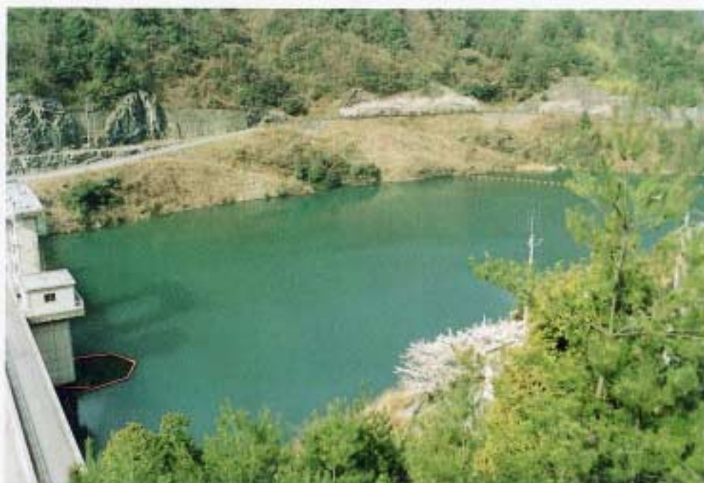
ダムサイトより上流を望む
