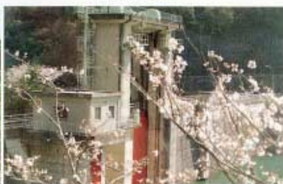
▲ 取水塔・放流ゲート・量水塔設備
