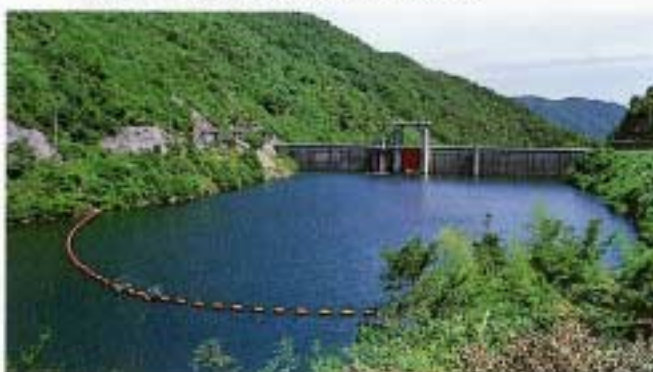
▲ 流木止網場施設
