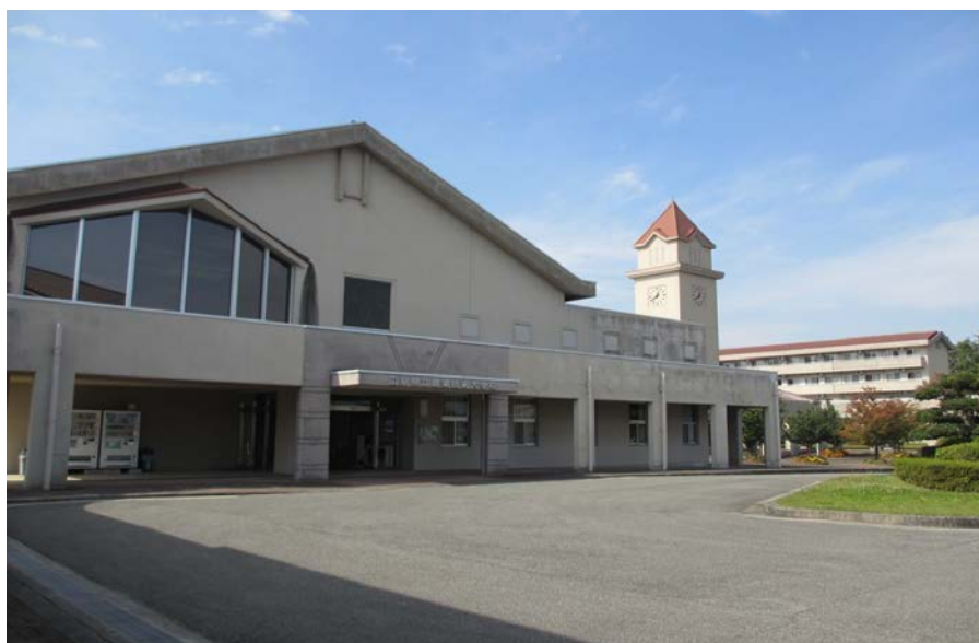
[県立農業技術大学校本館建物]
