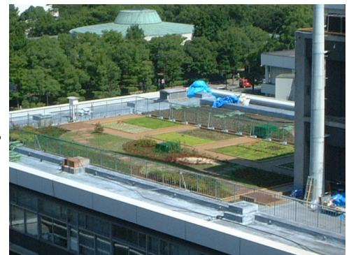
屋上緑化全景(県庁北館)
