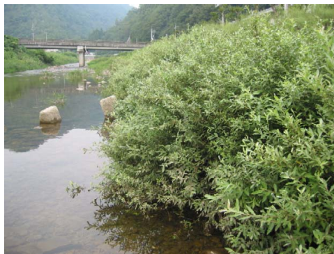
多自然型工法による河川整備（長瀬川）
